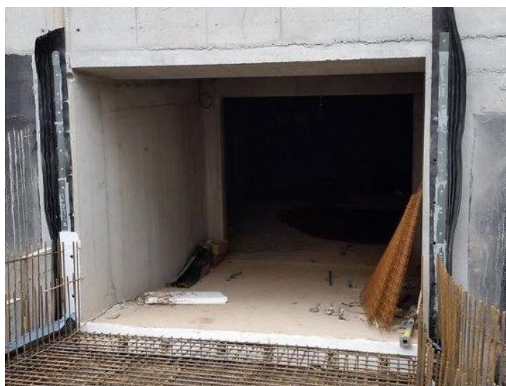
Obr. 10 Detail osazení dilatačního těsnícího pásu
